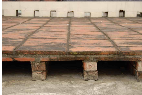
深水埗雷生春的平頂在屋頂覆蓋物加上磚頭支撐的廣東階磚，有助隔熱
