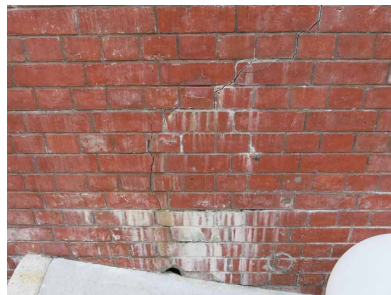
如在批盪裝飾上框處劃上滴水線或滴水槽，可以減少流水污跡。
