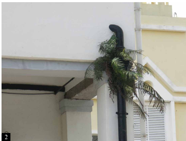
1, 2. 一棵細葉榕從檐槽和雨水斗生長出來
