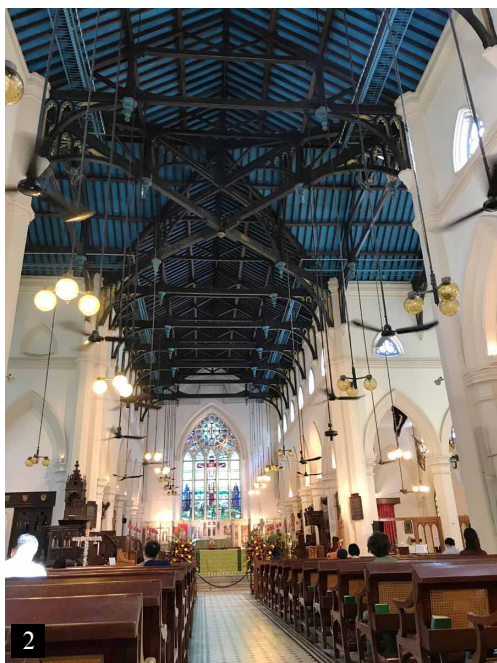
1. 赤柱美利樓的雙柱桁架上的天花木桁架 2. 中環聖約翰座堂的主入口
