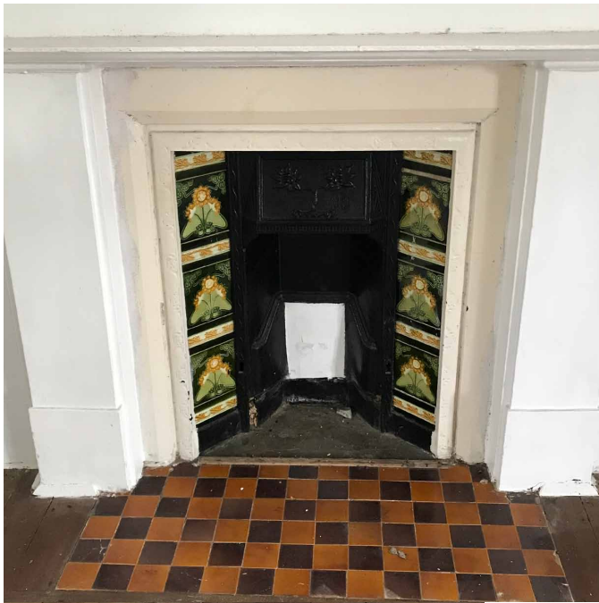
壁爐加入釉面瓷磚
