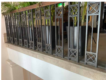
中環大館的鐵樓梯欄杆柱
