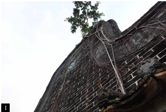
1. 樹根穿透磚牆的砂漿
