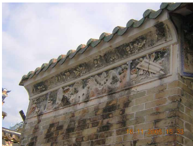
如在批盪裝飾上框處劃上滴水線或滴水槽，可以減少流水污跡。
