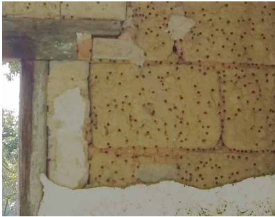
昆蟲在泥磚上留下孔蝕，將增加水分滲入的風險。
